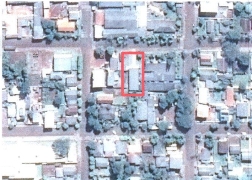
Figura 1: Vista aérea da Câmara Municipal de Palmital-PR
